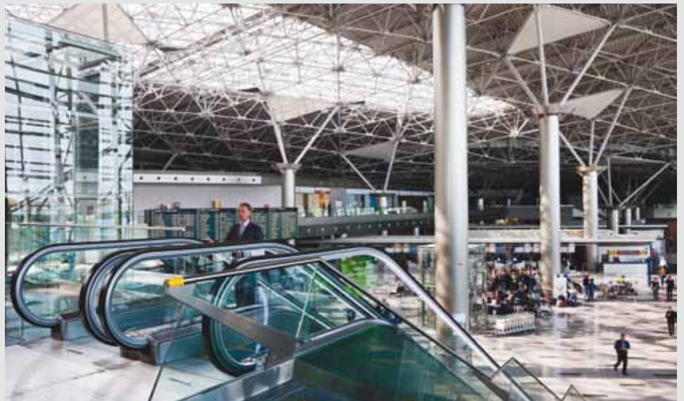
Die Fassaden der Terminals schimmern in schickem Himmelblau und Silbermetallic. Mitgebaut haben hieran auch deutsche Firmen.
