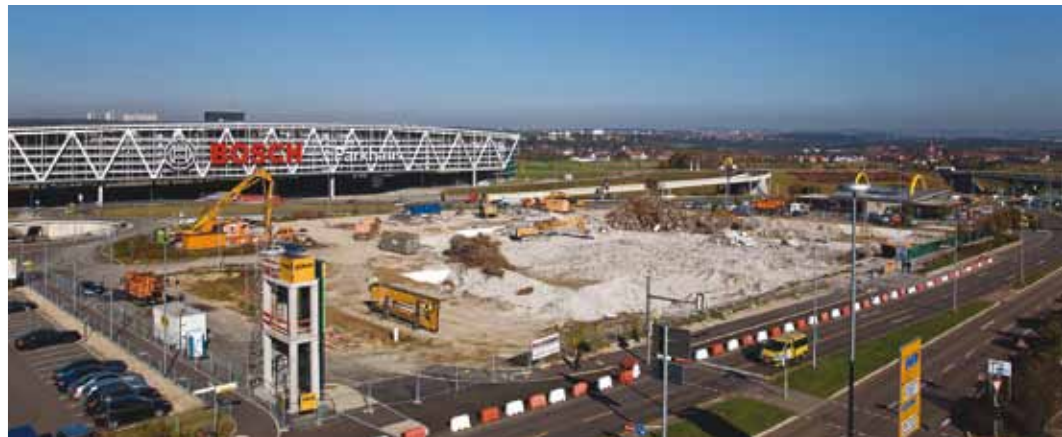
Wo früher Autos parkten, entsteht zurzeit die neue Deutschlandzentrale von Ernst & Young (EY).
