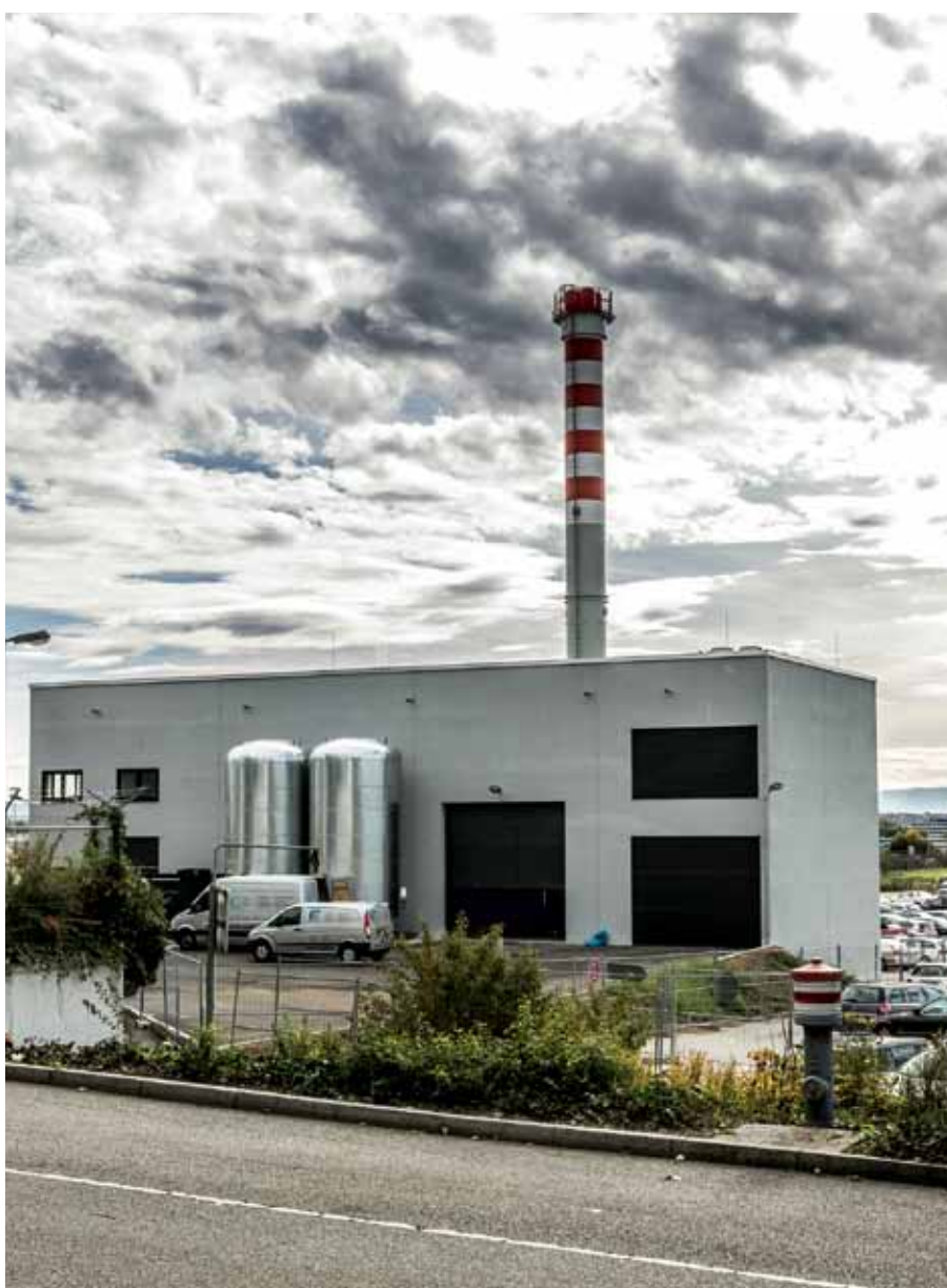
Das neue Blockheizkraftwerk soll bis 2020 zu einer deutlichen Einsparung bei den CO 2 -Emissionen auf dem Gelände beitragen.
