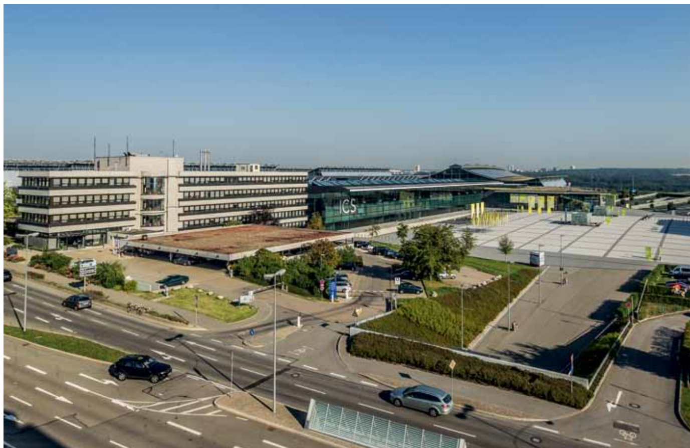
Die Gestaltung der Airport City ist ein wichtiges Vorhaben der Flughafengesellschaft. Die Flächen entlang der Flughafenstraße und in unmittelbarer Nachbarschaft zur Landesmesse spielen dabei eine wichtige Rolle.
